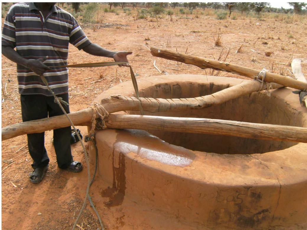
Photo 8 : Prélèvement d'eau souterraine au point d'eau N° 3.1 (village Tondidia Peul) avec un seau à corde
