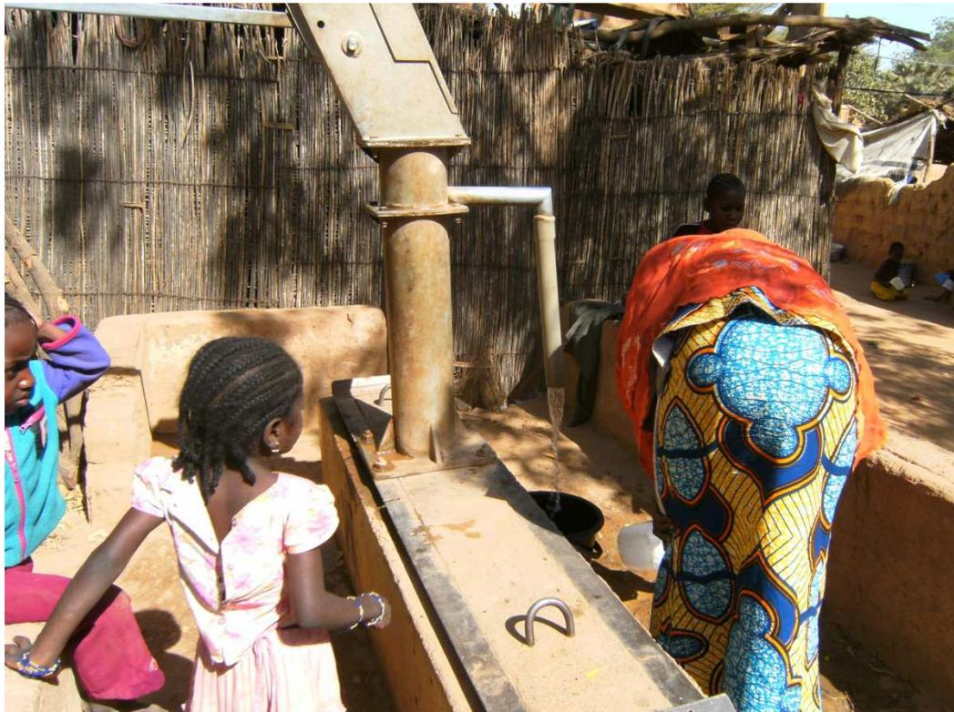
Photo 2 : Prélèvement d'eau souterraine d'un forage équipé (N°33) avec une pompe de motricité humaine (quartier « Kouara Mé »)
