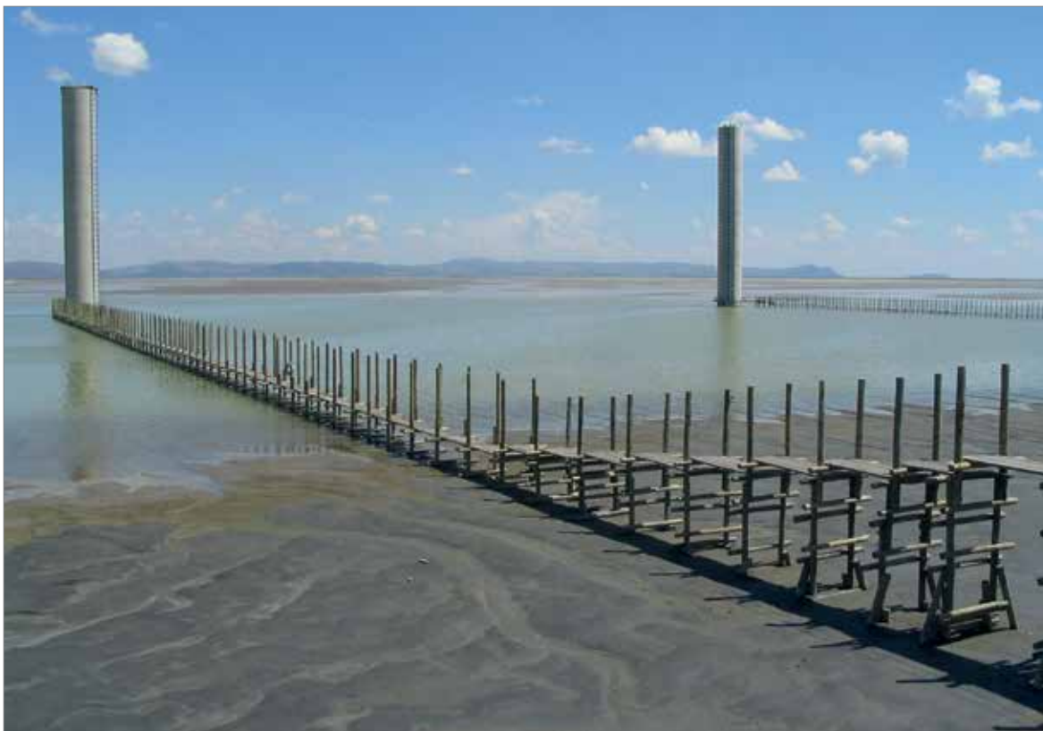
Abb. 60: Halde der Firma Impala Platinum Ltd. (ca. 220 Mio. t @ 0,7 g/t PGM 4E) (BGR 2008).
