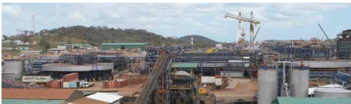
Abb. 52: Aufbereitungsanlage Mutanda Mining Sarl (Foto: BGR 2018).
