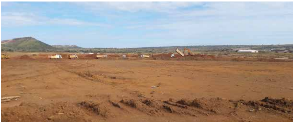
Abb. 55: Vorbereitende Arbeiten im Erdbau zur Errichtung der Aufbereitungsanlage auf der Konzession Mutoshi (Foto: BGR 2018).
