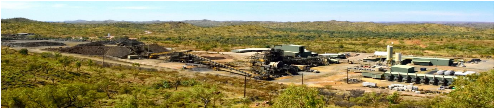
Aufbereitungsanlage Savannah des Unternehmens Panoramic Resources Ltd., Western Australia
