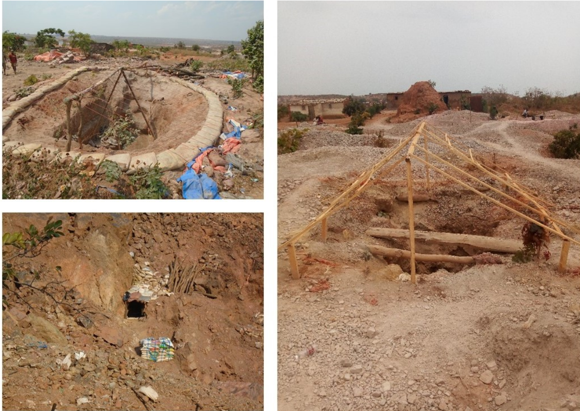
Abbildung 21. Die Bilder zeigen rudimentäre, teilweise nicht ausreichend durchgeführte Sicherungsmaßnahmen an Stollen- und Schachtmündern. Zu sehen ist, dass in der Regenzeit normalerweise Planen die Schächte abdecken um das Eindringen von Regenwasser und eine Destabilisierung des Schachtmundes zu verhindern.
