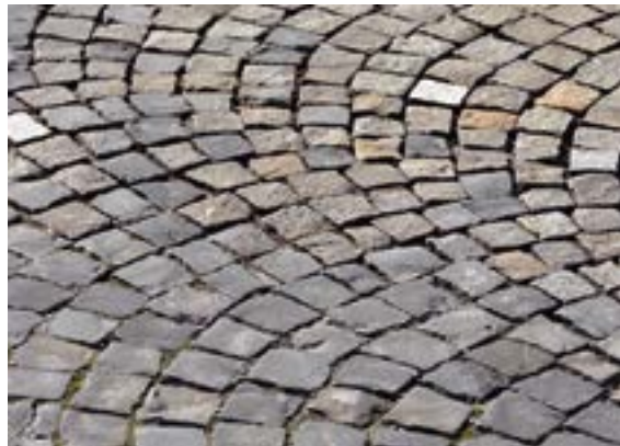
Pflastersteine werden in Pflastersand gebettet und danach die Fugen mit Einfegesand aufgefüllt, Foto: Anncapictures/pixabay.
