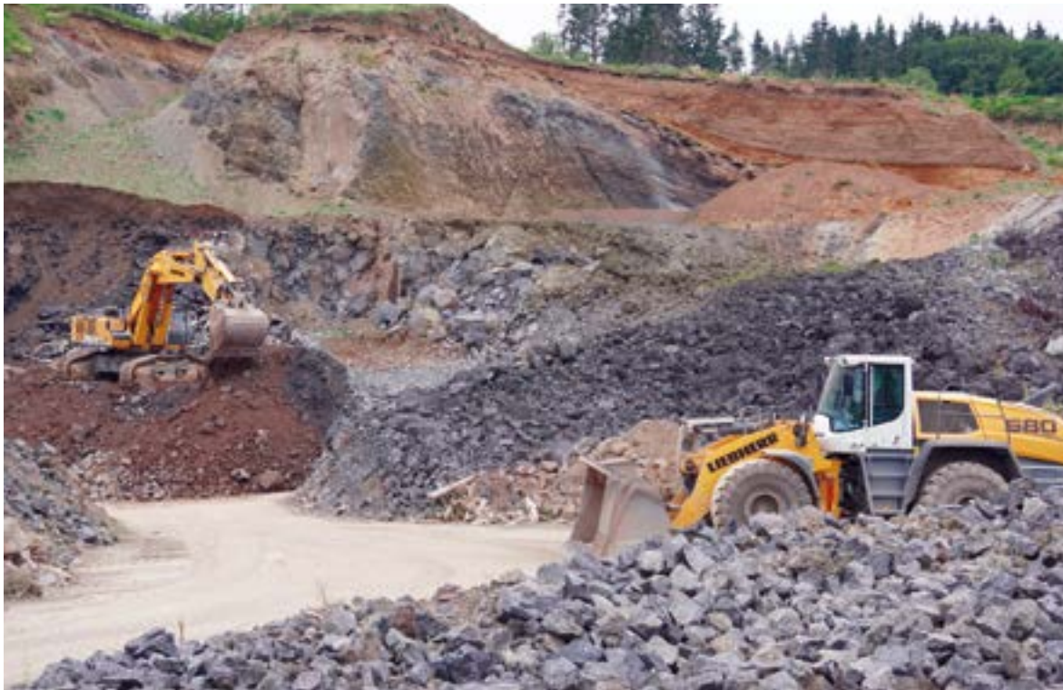
Am Südende der „Lavasandgrube Kirchweiler 3“ wird seit einigen Jahren kaum noch Lavaschlacke bzw. Lavasand (rotbraun), sondern vor allem Basaltlava (dunkelgrau) abgebaut, Foto: BGR.
