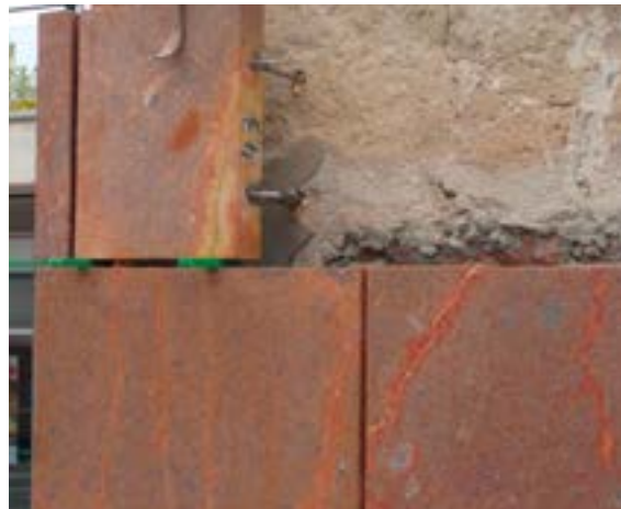
Montage einer Fassade aus Rochlitzer Porphyrtuff in Chemnitz, Foto: Lysippos/Wikipedia.
