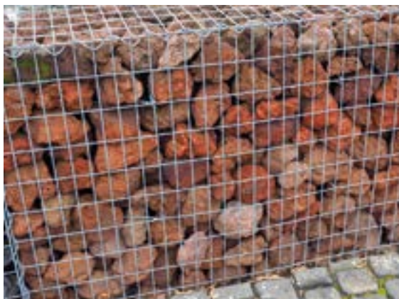
Mit grober Körnung aus Lavaschlacke gefüllte Gabione, Foto: Rheinische Provinzial-Basalt- und Lava- werke GmbH & Co. oHG (mit frdl. Genehmigung).
