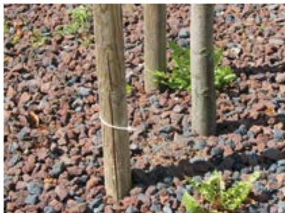
Mit einem jungen Baum neubepflanzte und mit grober Lavakörnung abgedeckte Pflanzgrube nach einer Straßensanierung, Foto: BGR.
