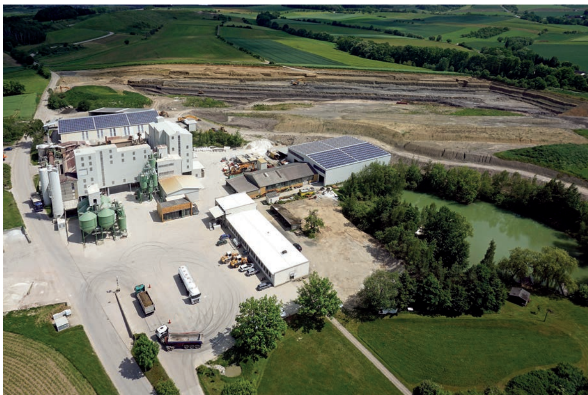
Bei Großheirath südlich Coburg werden rund 200 Mio. Jahre alte Tone abgebaut und im benachbarten Werk unter anderem zu Stückschamotte für die keramische und Feuerfestindustrie weiterverarbeitet, Foto: Adolf Gottfried Tonwerke GmbH (mit frdl. Genehmigung).
