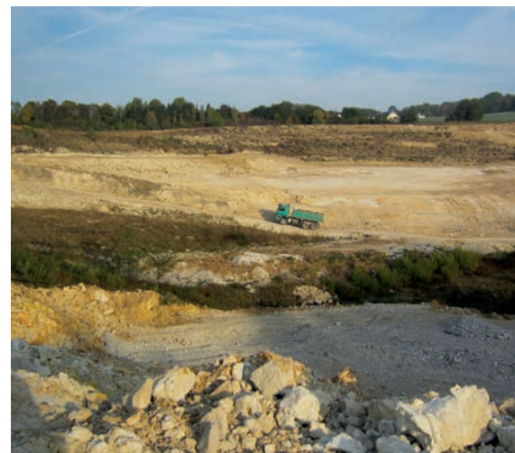
Mit Lkw werden die selektiv mit Hydraulikbaggern geförderten Tone aus dem Tontagebau „Niedersachsen-Nord“ in das benachbarte Aufbereitungswerk gebracht, Foto: BGR.
