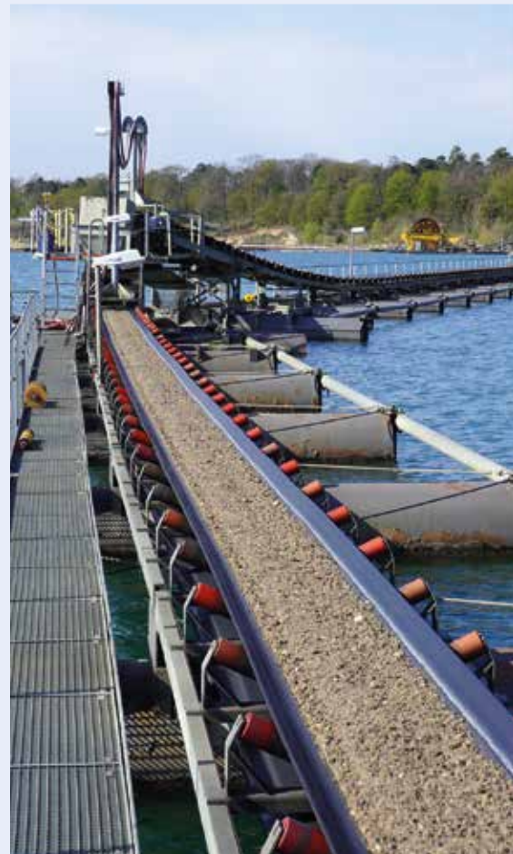
Rohkiessand von schwimmenden Gewinnungsgeräten wird meist über ebenfalls schwimmende Transportbänder in die Aufbereitungsanlage weitertransportiert, Foto: BGR.
