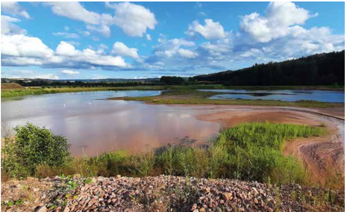
In allen größeren Kieswerken werden die Gesteinskörnungen gewaschen und dadurch weitgehend von abschlämmbaren Bestandteilen befreit. Das Brauchwasser wird mit den Feianteilen in bereits ausgekieste Areale des Baggersees oder in Waschschlammecken gepumpt, wo sich die Feianteile absetzen, oder wie hier im osthessischen KW Bebra, ausgedehnte Flachwasserzonen bilden. Diese sich ständig in der Lage verändernden Sedimentationsbereiche ähneln natürlichen Flussmäandern. Sie bilden den natürlichen Lebensraum von Watvögeln, wie dem Flussregenpfeifer, Vogel des Jahres 1993, Foto: Helmut Beisheim GmbH & Co. KG (mit frdl. Genehmigung).
