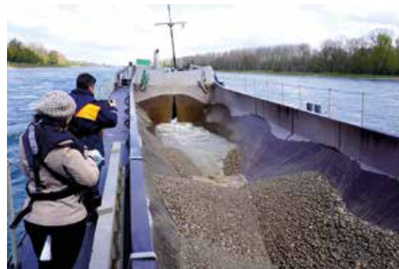
Kreislauf der Gesteine: Das im KW Iffezheim aus Rheinschottern gewonnene und aufwändig aufbereitete Korngemisch 0/63 mm wird zur Flussbettregulierung wieder im Rhein versenkt. Auch in zahlreichen anderen Flüssen in Deutschland wird diese Art von „Geschiebezugabe“ durchgeführt, Foto: BGR.
