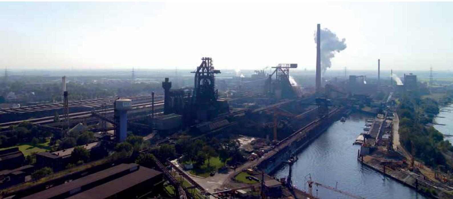
Blick auf die Hüttenwerke Krupp Mannesmann GmbH in Duisburg-Hüttenheim vom Kraftwerk Huckingen aus fotografiert, Foto: Michael Kümmling/Wikipedia.
