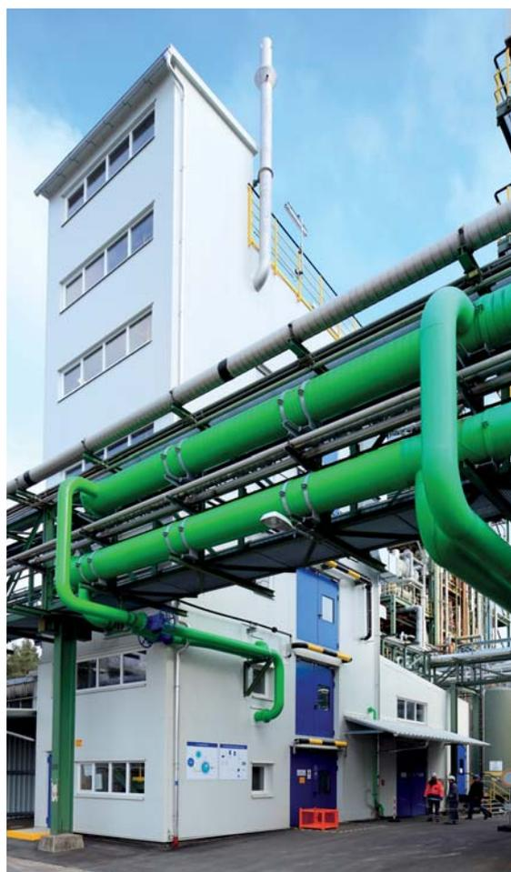
*In der weltweit ersten Recyclinganlage für Fluorpolymere im bayerischen Burgkirchen a. d. Alz werden jährlich bis zu 500 t Fluorpolymerabfälle in Monomere zerlegt und einer erneuten Fluorpolymerherstellung zur Verfügung gestellt, Foto: 3M Corporation (mit frdl. Genehmigung).*
