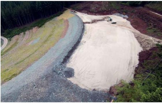
*Die Wiedernutzbarmachung der Haldenflächen (helles Material) der Grube Clara wird durch das Aufbringen einer Schottererschicht und einer Mulchung mit Heu erreicht, Foto: Sachtleben Bergbau GmbH & Co. KG (mit frdl. Genehmigung).*
