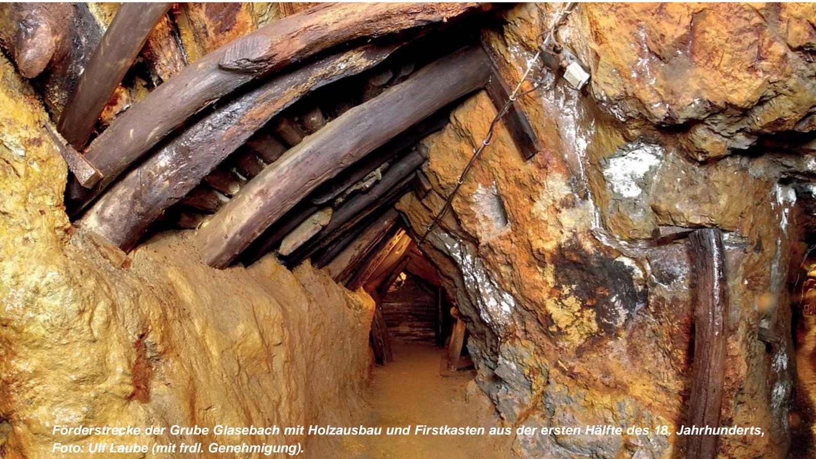
*Förderstrecke der Grube Glasebach mit Holzausbau und Firstkasten aus der ersten Hälfte des 18. Jahrhunderts, Foto: Ulf Laube (mit frdl. Genehmigung).*
