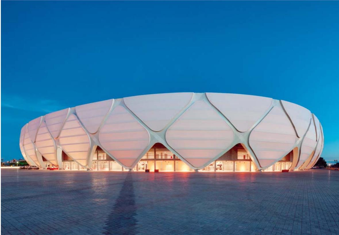
*52.000 Quadratmeter PTFE-beschichtete Glasfasermembranen schützen in der „Arena da Amazônia“ vor direkter Sonneneinstrahlung bei gleichzeitig guter Belüftung. Das verwendete Glasfasergewebe hat eine hohe Zugfestigkeit und wiegt lediglich 1 – 1,5 kg/m<sup>2</sup>. Foto: 3M, Copyright M. Bredt (mit frdl. Genehmigung).*
