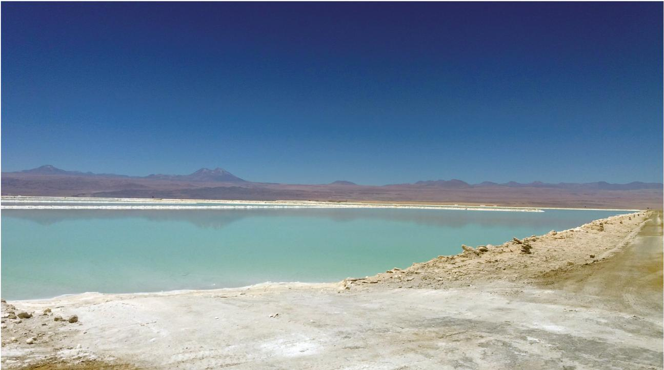
**Abb. 6:** Verdunstungsbecken zur Konzentrierung und Reinigung von lithiumhaltiger Sole der Firma Albemarle im Salar de Atacama, Chile, Foto: BGR.
