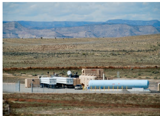
Abb. 21: Heliumanlage von IACX Energy auf dem Harley-Dome-Erdgasfeld mit \varnothing 7,0 % He in Utah, Foto: www.iacx.com .
