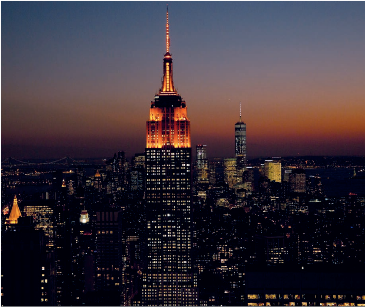
Abb. 17: Im Jahr 2010 wurden nacheinander jede Nacht jeweils 50 der insgesamt 6.379 Fenster des Empire State Buildings in New York ausgebaut, die Glaszwischenräume mit einer Metallfolie beschichtet, dann mit einem Gasgemisch aus Luft, Argon und Krypton gefüllt und abschließend wieder eingebaut. Hierdurch ging der Wärmeverlust durch die Fenster um 75 % zurück, Foto: UN Women/Ryan Brown.
