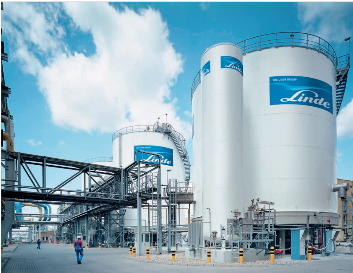
Abb. 49: Die Luftzerlegungsanlage in Leuna produziert neben Sauerstoff, Stickstoff und Argon auch Rohneon, Rohkrypton/Rohxenon sowie Helium, Foto: Linde AG (mit frdl. Genehmigung).
