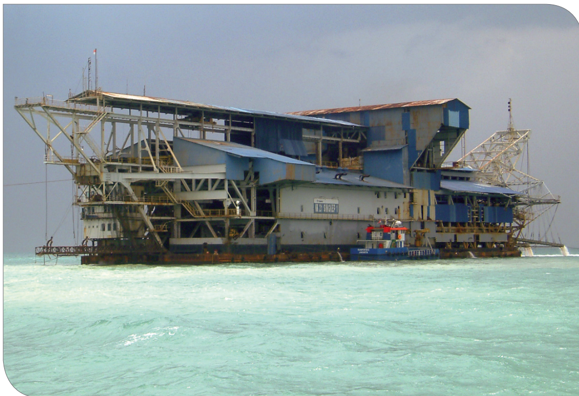
Abb. 1: Eimerkettenbagger von PT Timah offshore Bangka Island, Indonesien.
