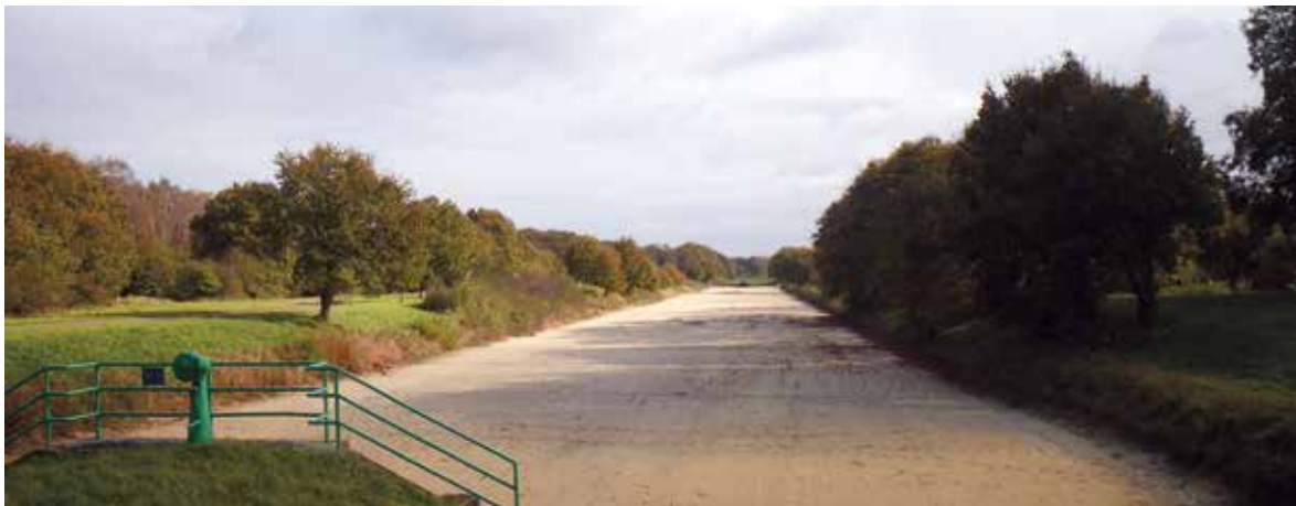
Sogenannter Langsandsandfilter, bei dem Oberflächenwasser durch Halterner Quarzsande in den Untergrund infiltriert und später durch Brunnen als (schon vorgereinigtes) Rohwasser wieder gefördert wird, Foto: DVGW e.V. (mit frdl. Genehmigung).
