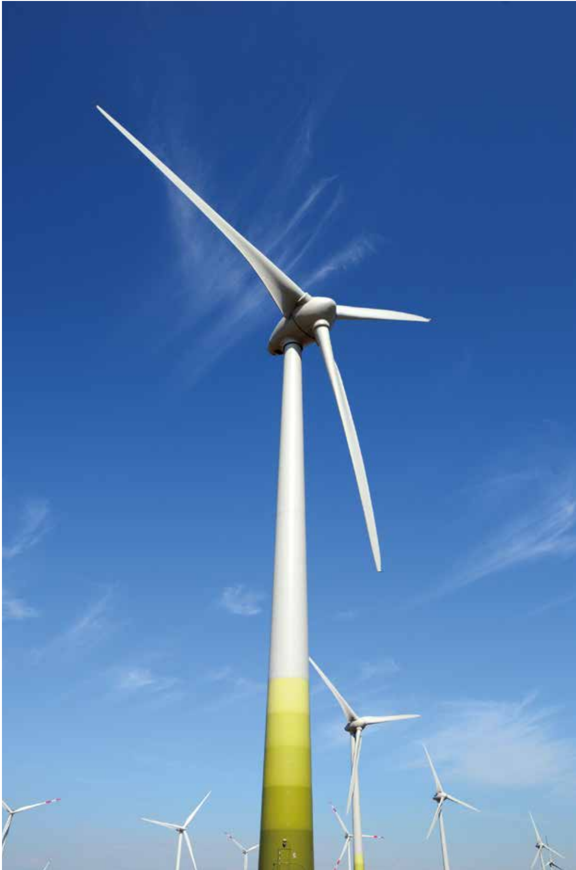
Glasfaserverstärkte Kunststoffe sind das bevorzugte Material für Rotoren von Windkraftanlagen. Die Glasfasern wiederum werden aus hochwertigem Quarzsand hergestellt, Foto: © VRD – Fotolia.com
