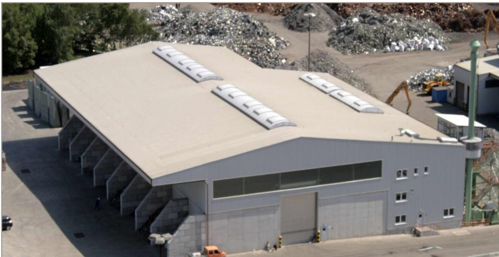
Aurubis Probenahmeanlage für Leiterplatten, Lünen
