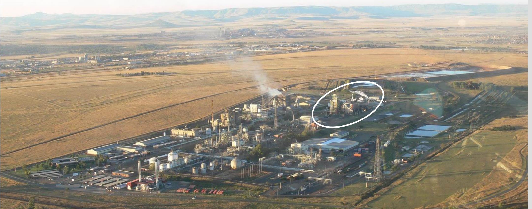
Natriumdichromat Produktionsanlage in Südafrika
