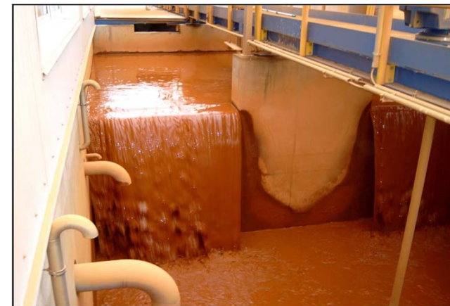
KS- und ÜS-Schlammbecken
